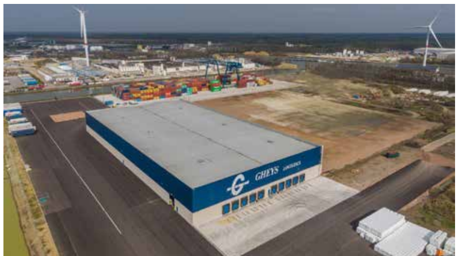
In de nieuwe lay-out in Beringen is gezorgd voor een magazijn met een meer logische structuur, in combinatie met betere toewijzing van goederen aan de verschillende zones via ABC-allocatie. Producten die diep in het magazijn gelokaliseerd zijn, worden via een 'staging in' en 'staging out' zone nu ook ontkoppeld van het laden en lossen.
