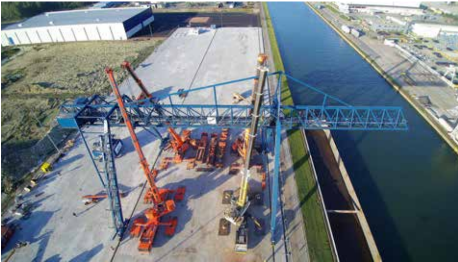
De nieuwe terminal aan het Albertkanaal heeft een capaciteit van meer dan 50.000 containers, wat Gheys Logistics meteen een ruime marge voor de toekomst biedt en maakt dat er nog meer vrachtwagens van de weg af kunnen worden gehaald.
